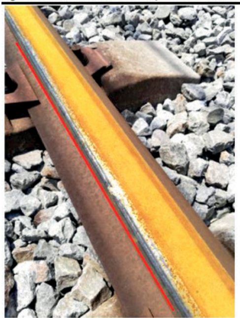
Figura IV.1.22 - Detalles de la superficie del carril
