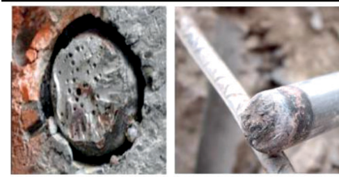
Figura IV.1.8 - Detalle de los pernos Nelson
