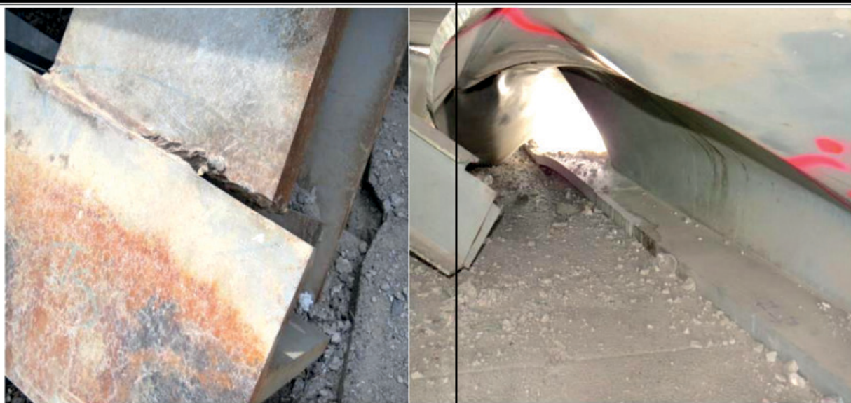
Trabe T-7 mostrando deformación y desprendimiento de la luminaria de soporte
