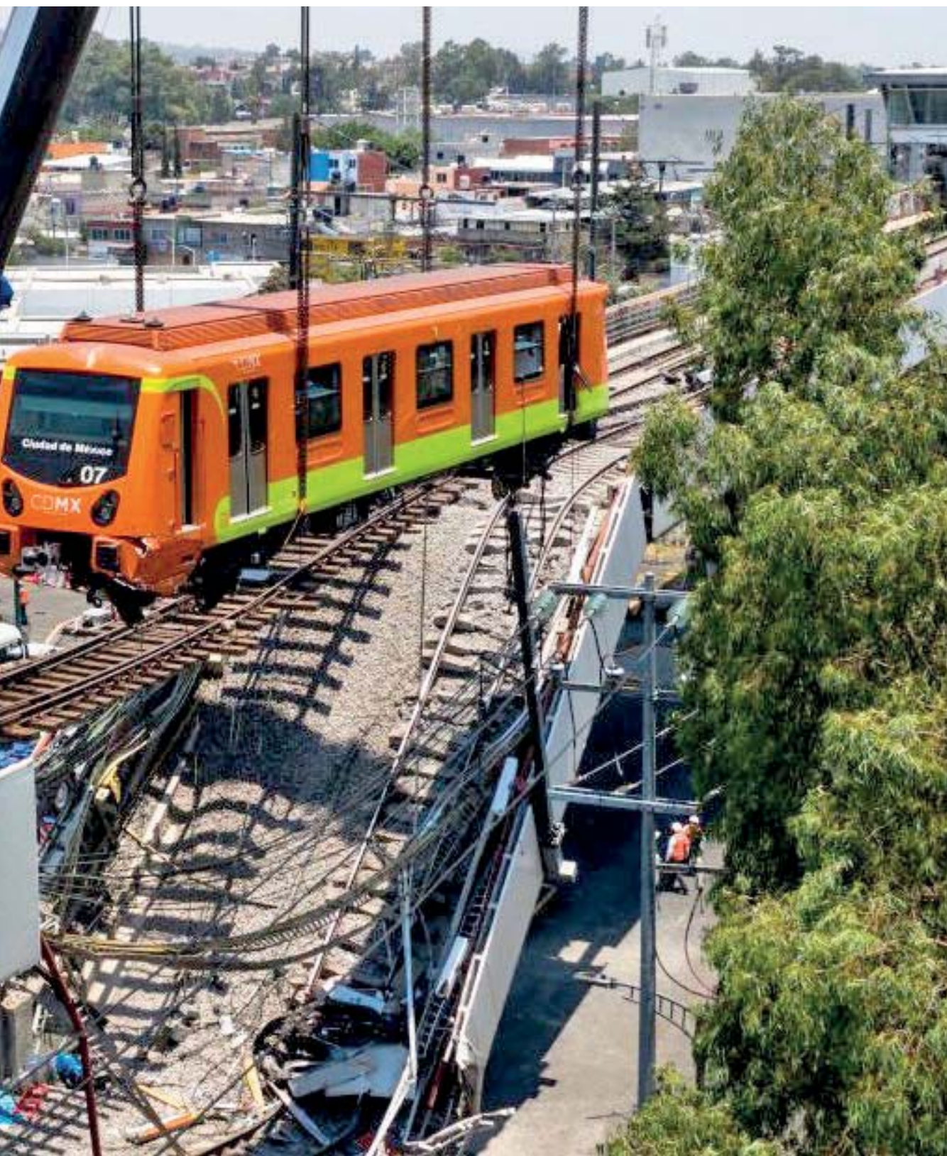
Figura IV.1.12- Trabe T-6 girder- trabe puente
