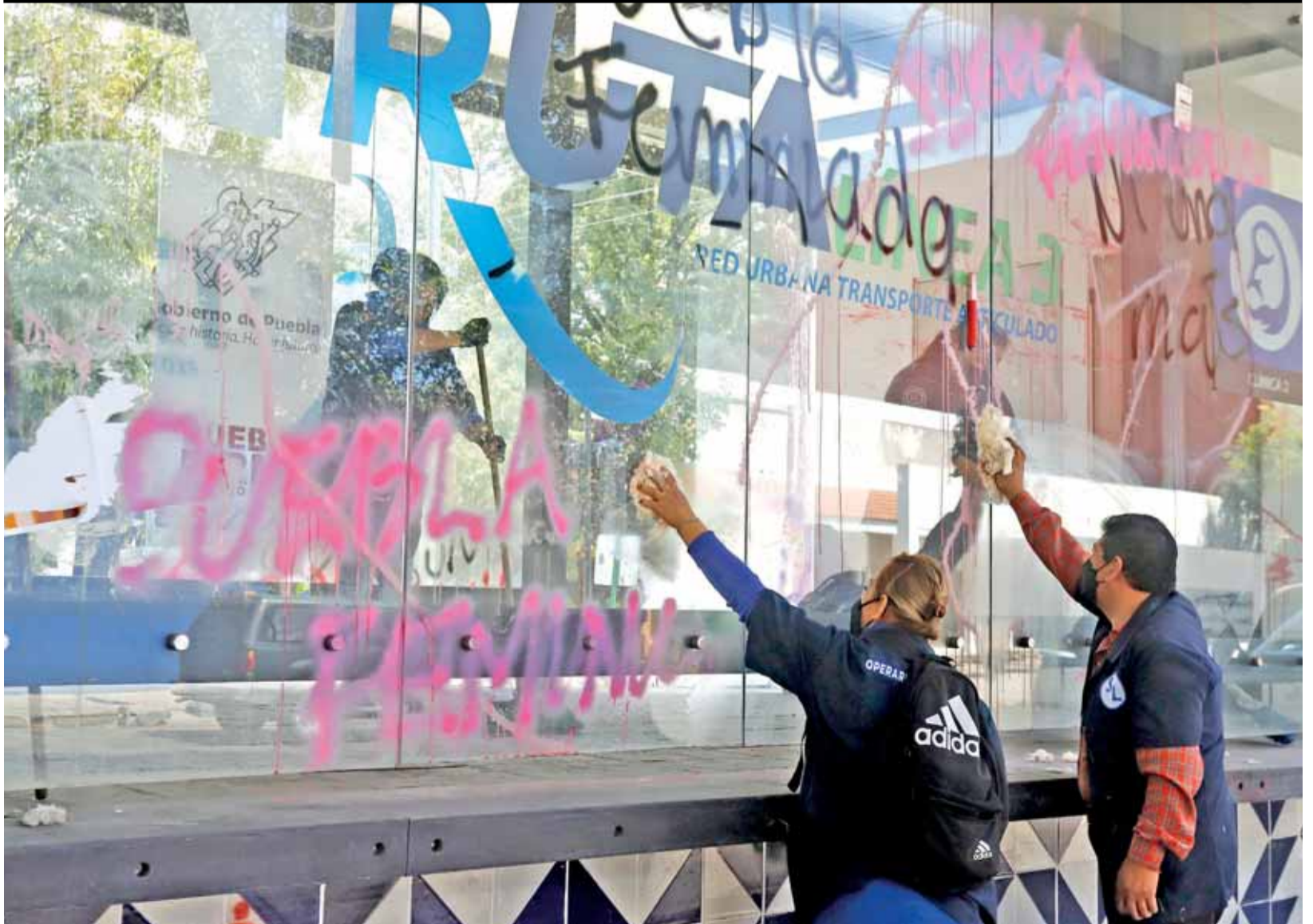
Personal de RUTA realizó limpieza y reparación de las estaciones de la línea 3, tras haber sido vandalizados por grupos feministas durante la marcha del 8M.
